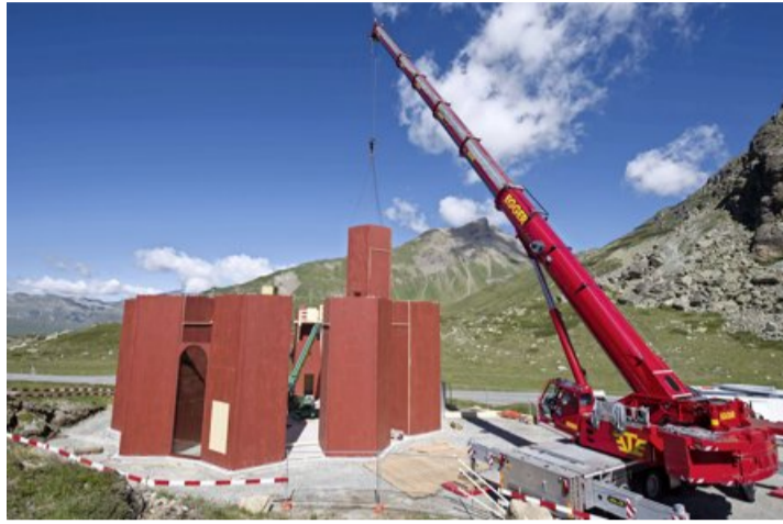
Débutée fin mai, la construction doit se terminer le 31 juillet.
